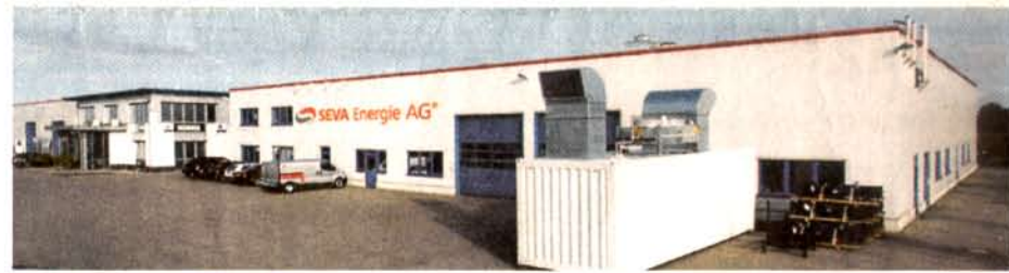
Platz für Lager und Produktion: Das Firmengebäude von Seva Energie in Emstek.
